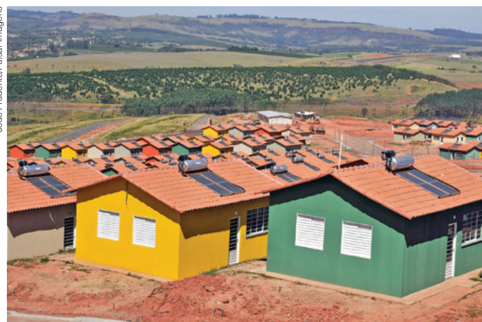
↑ Casas com placa solar e aquecedor solar de água em conjunto habitacional. São Sebastião do Paraíso (MG), 2014.
