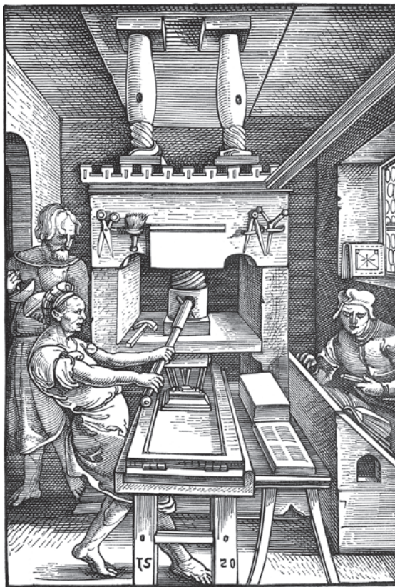
Uma impressora em 1520. Os impressores acionam a manivela, que pressiona a superfície entintada sobre o papel. Gravura em xilogravura, publicada em 1879.
