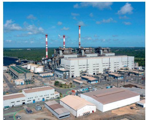
Usina Termoeletrica do Complexo Industrial e Portuário do Pecém, em São Gonçalo do Amarante (CE), 2022.
