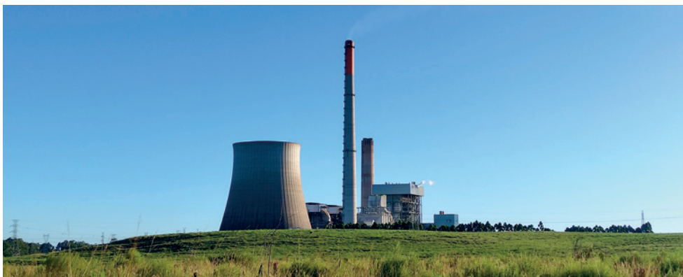
Usina termelétrica de Candiota (RS), 2021. Única usina a carvão da Eletrobrás. Esta usina foi vendida para a iniciativa privada como parte do esforço da empresa de reduzir as emissões de carbono e realizar a transição energética.
