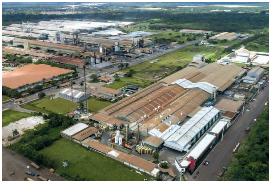
Vista aérea do polo industrial siderúrgico e metalúrgico destinado à produção de alumínio. Barcarena (PA), 2019.
