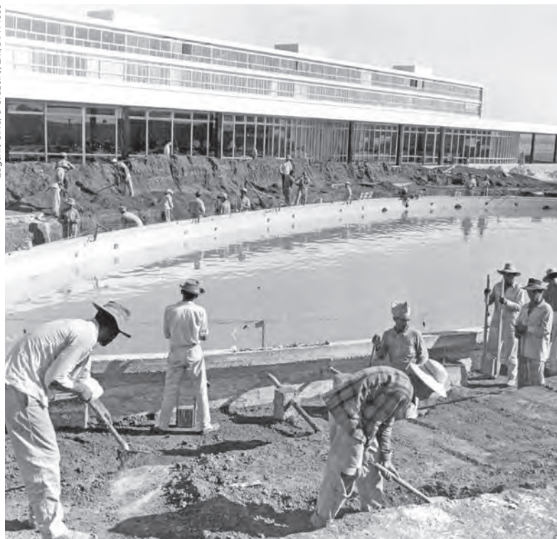
Trabalhadores na construção de Brasília, a nova capital federal, em 1959.
