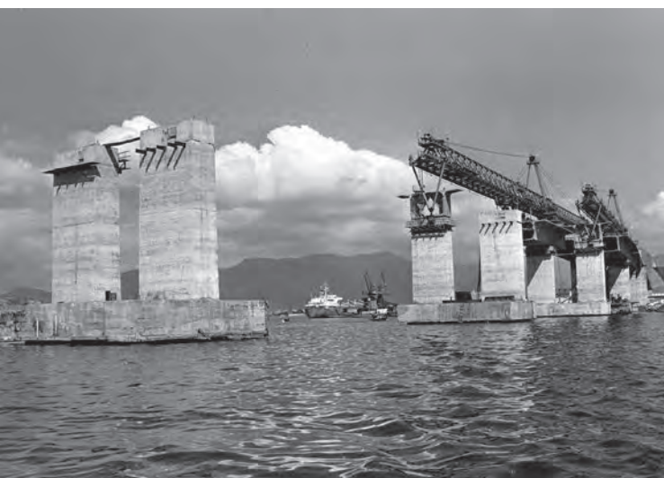
A construção da Ponte Rio-Niterói (RJ), no início da década de 1970 (foto de 1971), foi um marco da engenharia civil brasileira, com seus 13 km de extensão.
