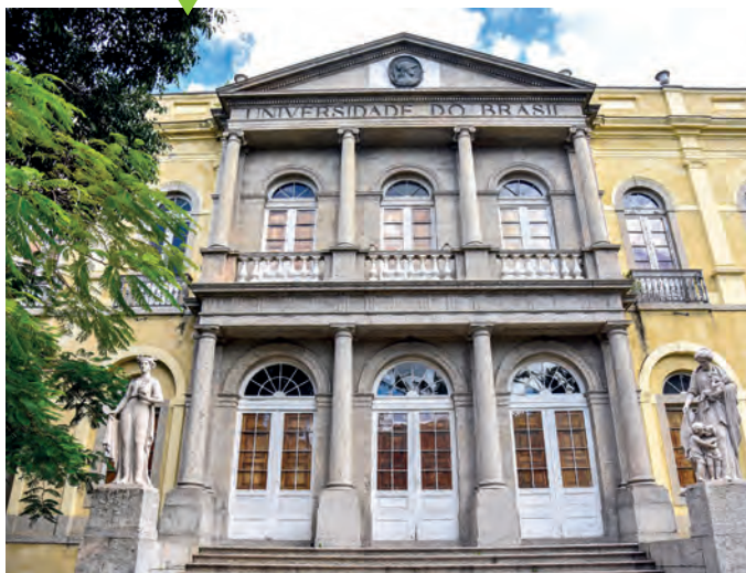
Palácio Universitário da Universidade Federal do Rio de Janeiro (UFRJ). Rio de Janeiro (RJ), 2020.
