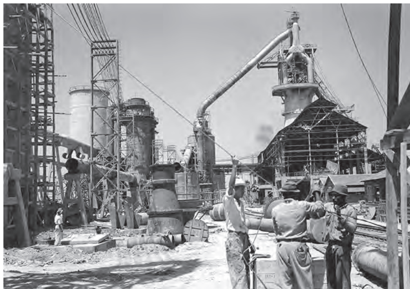
Construção da Companhia Siderúrgica Nacional (CSN). Volta Redonda (RJ), 1941.
