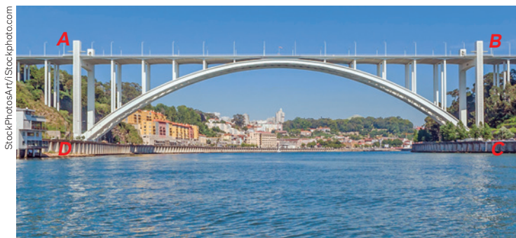
Ponte da Arrábida, Porto, Portugal, 2017.
