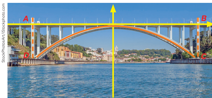
Ponte da Arrábida, Porto, Portugal, 2017.
