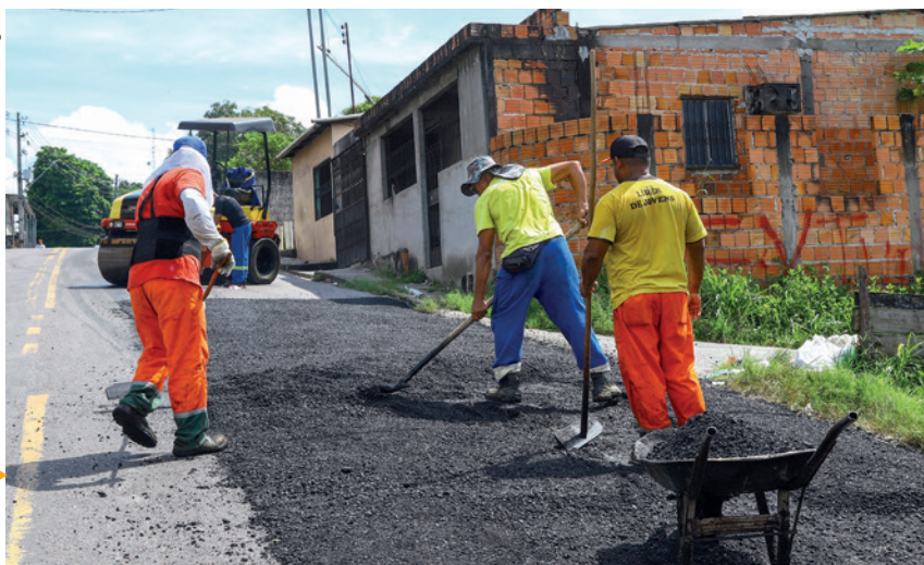
Trabalhadores fazem o recapeamento de asfalto. Manaus (AM), 2022.
