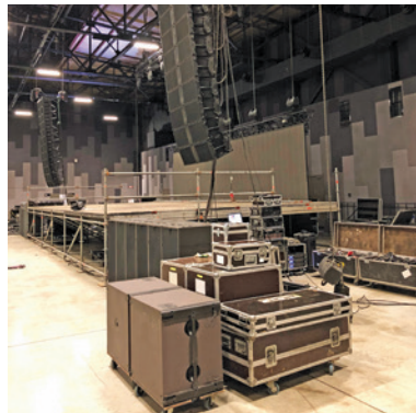
Sistema de sonorização com arranjo em linha ( line array ). À esquerda, sua montagem em um palco, ao centro, as caixas de som alinhadas e, à direita, o perfil geométrico cilíndrico da frente das ondas sonoras.
