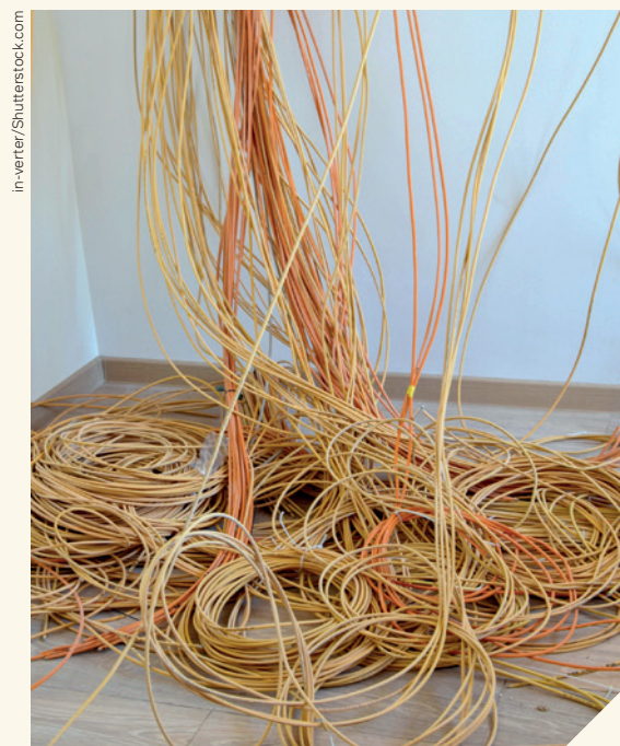
Instalação de cabeamento suspenso, 2023.
