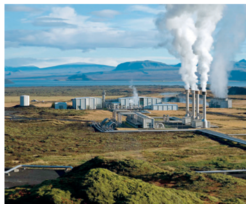
Usina geotérmica na Islândia, 2006.
