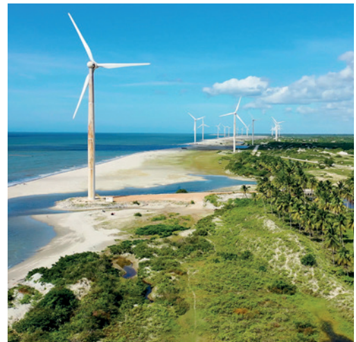
Parque eólico em praia no Ceará, 2023.
