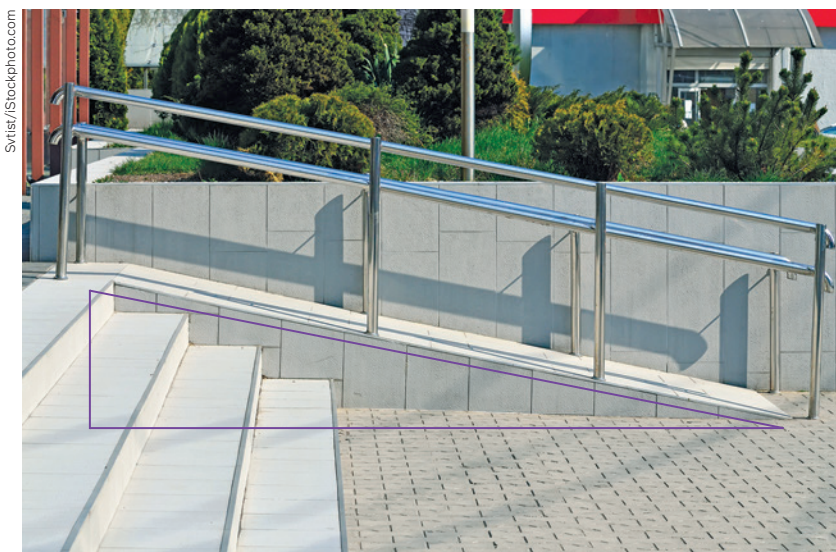
Escada e rampa de acesso na entrada de um estabelecimento.
