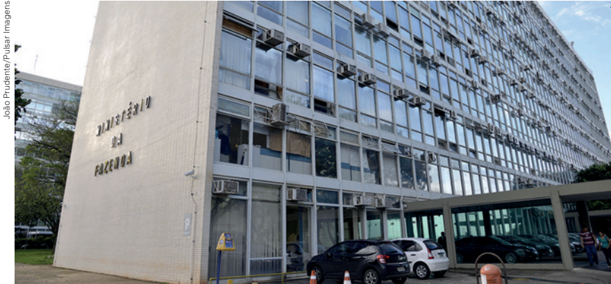
Prédio do Ministério da Fazenda na Esplanada dos Ministérios, Brasília (DF), 2015.
